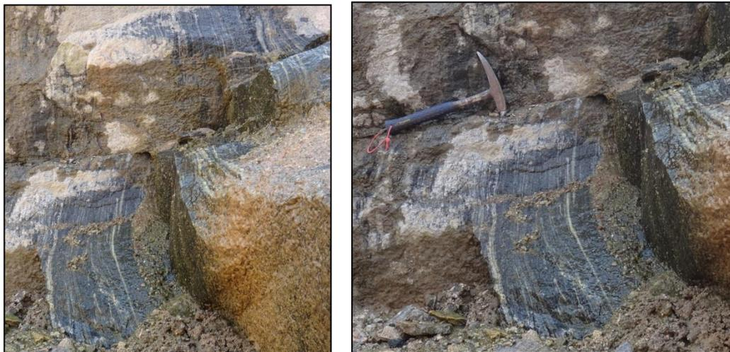
Figura 5.4 – Detalhe da foliação marcante na rocha do desemboque e fraturas escalonadas.
