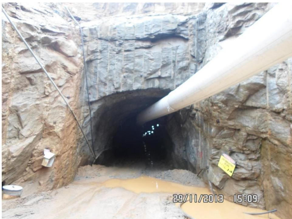
Figura 6.12 – Emboque do túnel já escavado.
