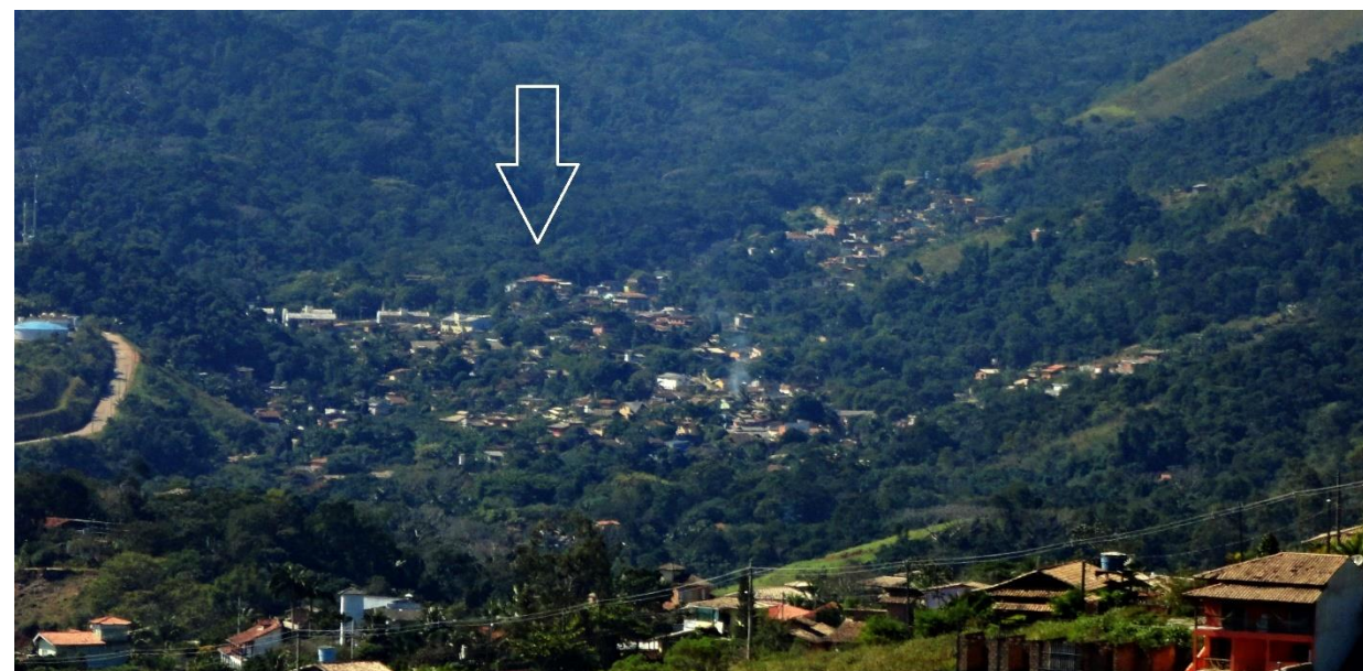
Vista panorâmica da unidade (ponto 10)
