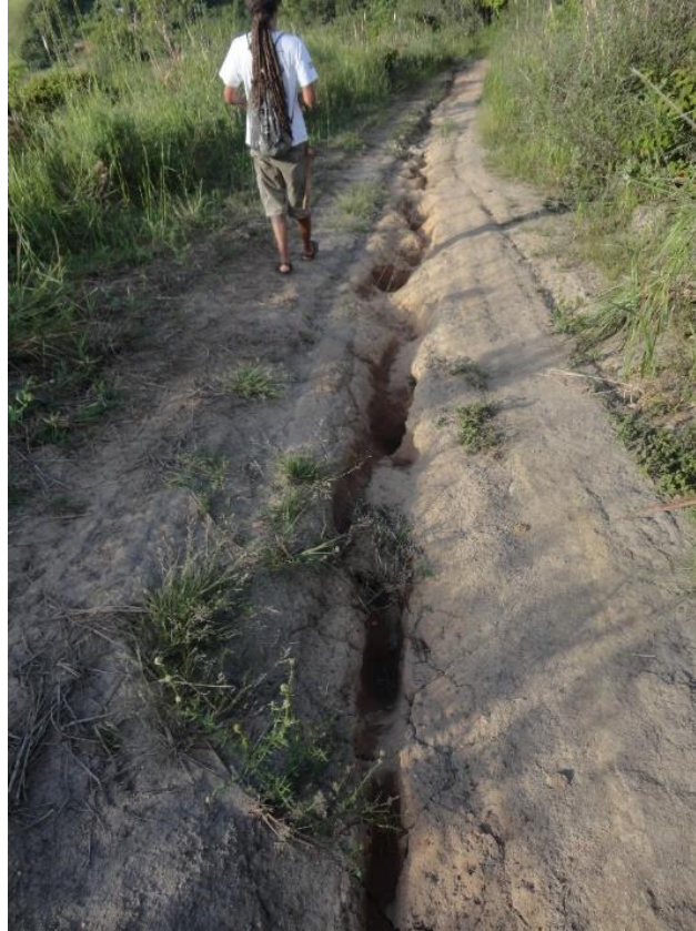
Figura 27: Erosão linear em estrada de terra (ponto 61).
