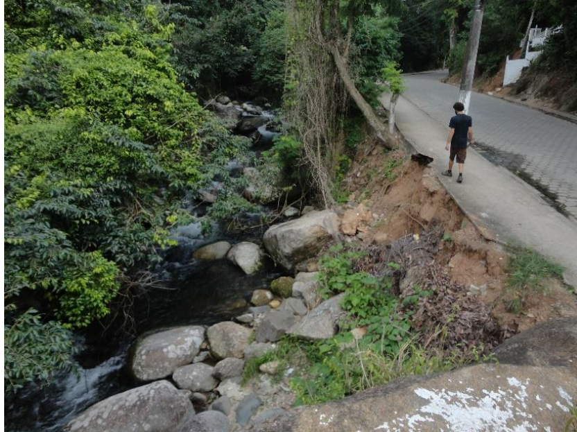
Figura 34: Processo de erosão marginal em área urbanizada (ponto 26)
