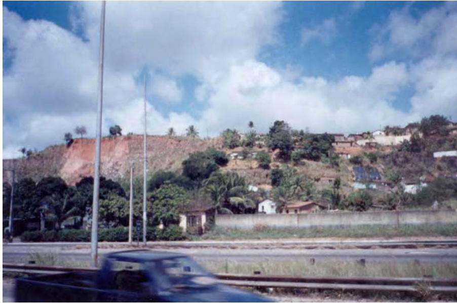
Foto 4.2: Vista de área de risco ao longo da BR-101, próximo à localidade de Cidade Tabajara no Município de Olinda.
