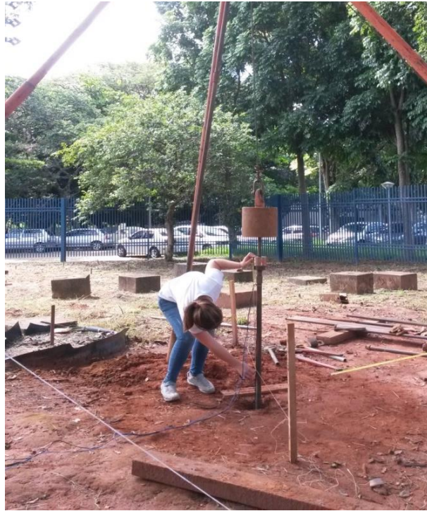
Figura 5.2 Controle da penetração permanente do amostrador por golpe do martelo.
