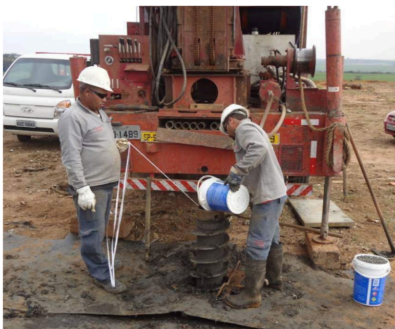
Figura 4.9 – Colocação da brita no furo de sondagem e medida da profundidade com trena, durante a operação de retirada dos segmentos de trado de dentro do furo de sondagem.
