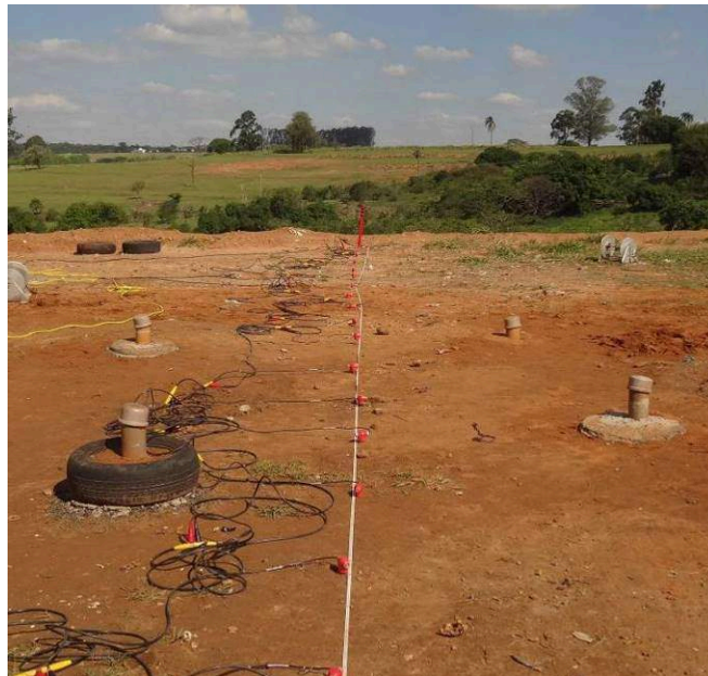
Figura 4.12 – Detalhe da execução da L3 do ensaio MASW, que passa entre os furos utilizados nos ensaios crosshole .
