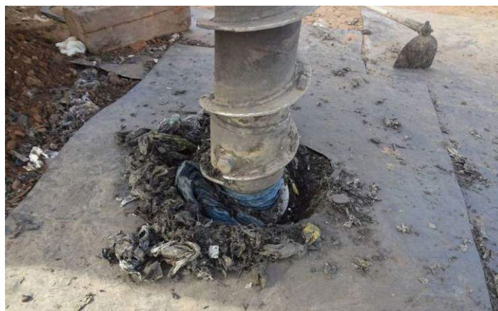
Figura 4.7 – Resíduos chegando à superfície, trazidos pela composição de trados helicoidais.
