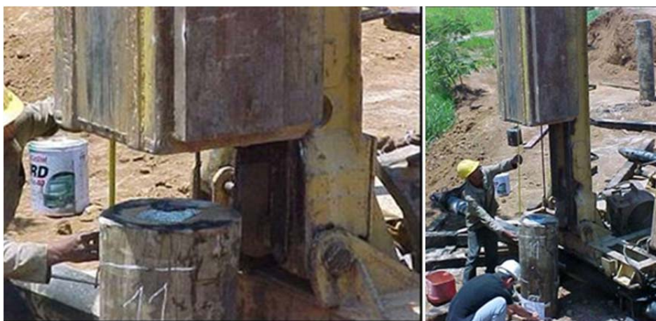
Figura 2.28 – Controle de altura na execução da PCD com energia crescente (Miná, 2005).
