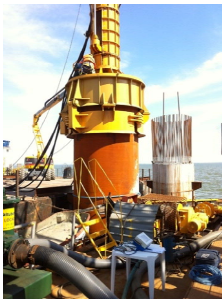
Figura 2.25 – Execução com martelo hidráulico em camisa metálica (Rosa, 2013).
