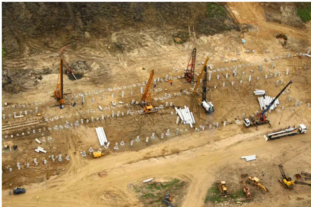
Figura 3.5 – Vista aérea da execução do projeto (SCAC, 2012).
