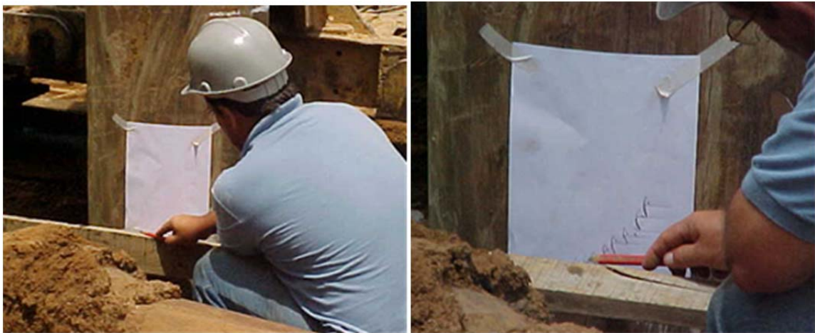
Figura 2.13- Obtenção de nega e repique através do método de Chellis (Miná, 2005).
