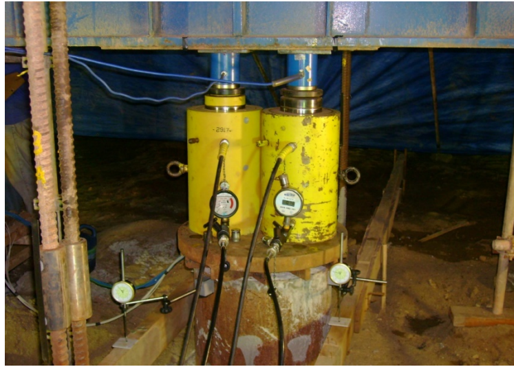
Figura 2.5 – Arranjo da montagem de uma prova de carga estática.
