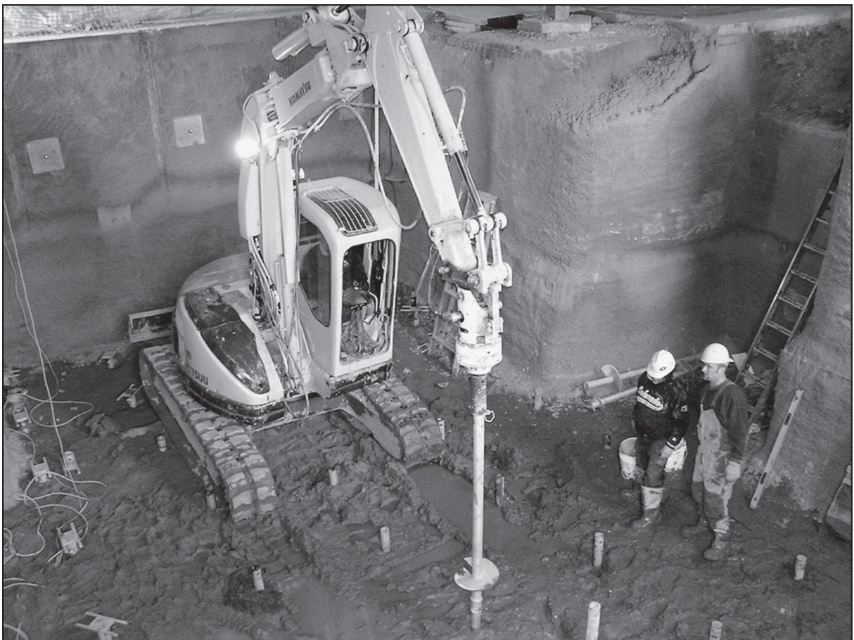
Figura 2. 4: Adaptação do motor hidráulico em uma retro escavadeira (Perko, 2009)
