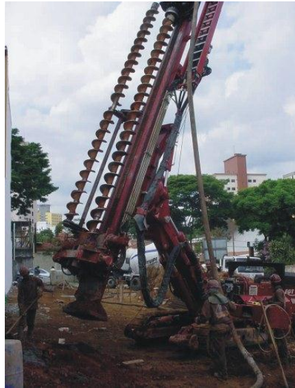
Figura 2.36 Vista da perfuratriz operando com dois segmentos de trados.(ENGESTRAUSS, 2002).
