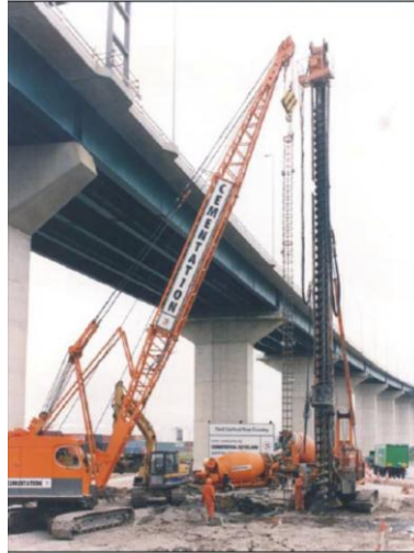
Figura 2.5 Introdução da armadura na estaca. (FHWA, 2007).
