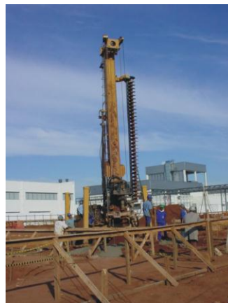
Figura 2.42 Vista do equipamento modificado. Fase de escavação. (E.G. BARRETO, 2010).
