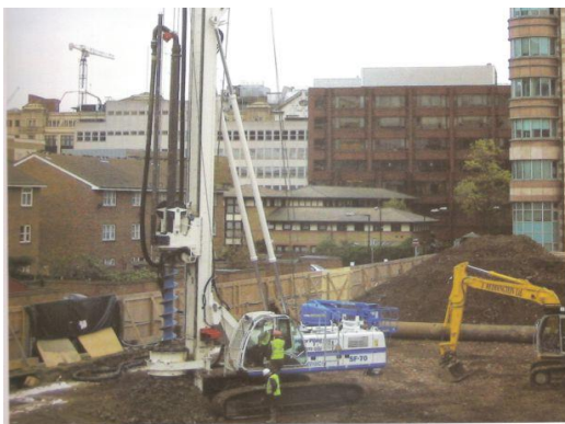
Figura 2.18 Perfuratriz SF-70-Vista parcial. (SOILMEC, 2010).
