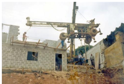
Figura 2.56 – H 1000 – Implantação em obra com utilização de guindaste (E.G.Barreto, 199-?).
