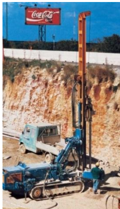
Figura 2.93 Perfuratriz MK 2000D em execução de estaca raiz. (CMV, 2008).
