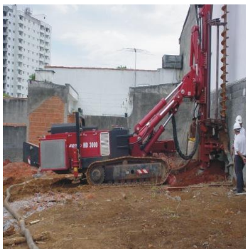
Figura 2.35 Execução de estaca próxima à divisa. (ENGESTRAUSS, 2002).
