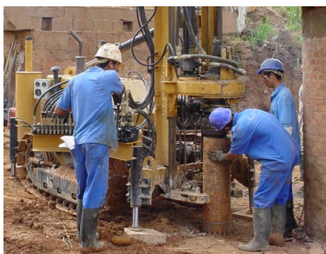
Figura 2.73 Posicionamento e introdução do tubo de revestimento no terreno (EG BARRETO, 2005)
