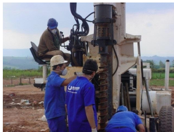
Figura 2.70 Perfuratriz HT 7 10 – Execução de sondagens em aterro sanitário, no município de Leme – SP. (E.G. Barreto, 2004).
