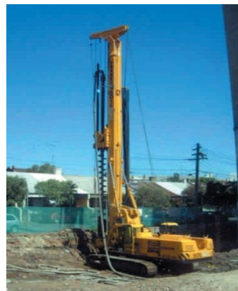
Figura 2.19 Perfuratriz R-1240 CFA (SOILMEC, 2005).
