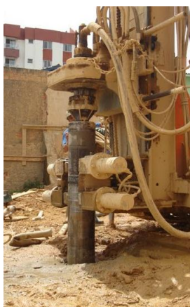
Figura 2.83 Extração do tubo de revestimento. (NEVES, BIESUZ & VENTURA, 2008).
