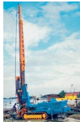
Figura 2.94 Perfuratriz MK 2000D em execução de Jet Grouting (CMV, 2008).
