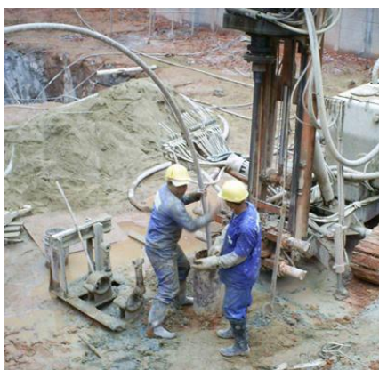
Figura 2.80 Introdução do tubo de injeção. (LEITE; GIRARDI; SOUZA, 2007).
