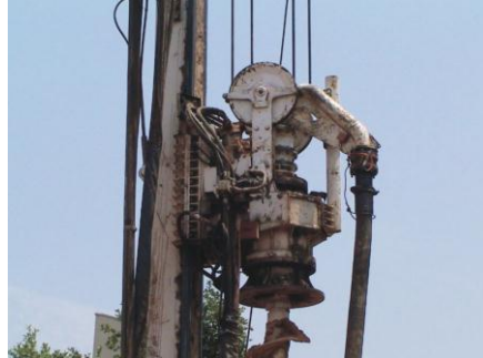
Figura 2.3 Vista da ligação do mangote ao tubo central da hélice. (GEOESP, 2010)
