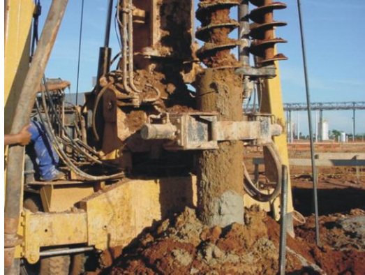
Figura 2.43 Vista do equipamento modificado. Fase de concretagem. (E.G.BARRETO, 2008).
