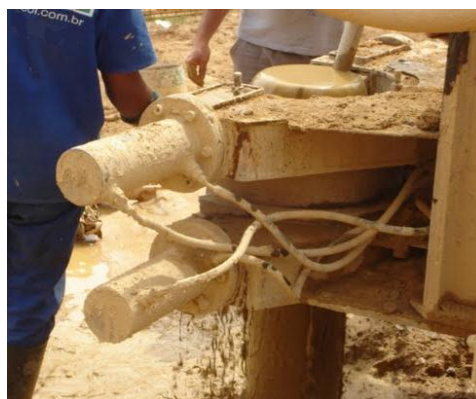
Figura 2.75 Circulação de água (NEVES, BIESUZ & VENTURA, 2008).
