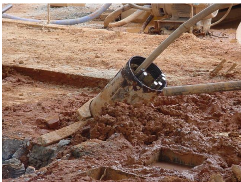
Figura 2.81 Injeção da argamassa. (EG BARRETO, 2007).
