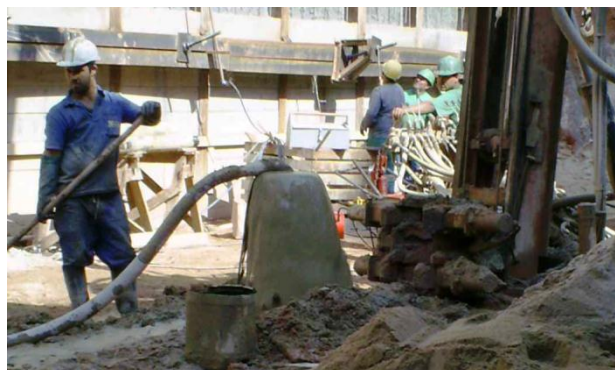
Figura 2.82 Extravasamento da argamassa injetada. (LEITE, GIRARDI & SOUZA, 2007).
