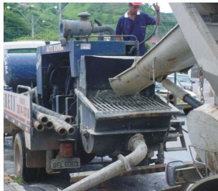
Figura 2.4 Bomba de concreto montada sobre caminhão. (ENGESTRAUS, 2005).
