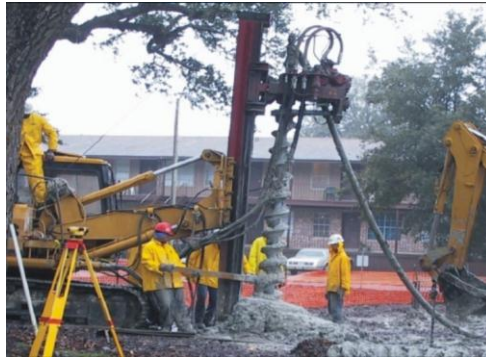
Figura 2.45 Equipamento para execução de estacas com trados segmentados. (FHWA - Federal Highway Administration, 2007).
