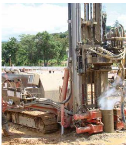
Figura 2.88 Perfuratriz MC180 em atividade com martelo de fundo. (CZM, 200-?).
