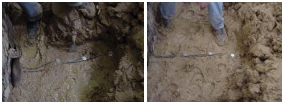
Figura 21 – Instalação das células de tensão total (MENESES, 2004)
