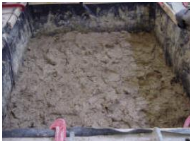
Figura 20 – Aspecto do solo mole de fundação dos ensaios (MENESES, 2004)
