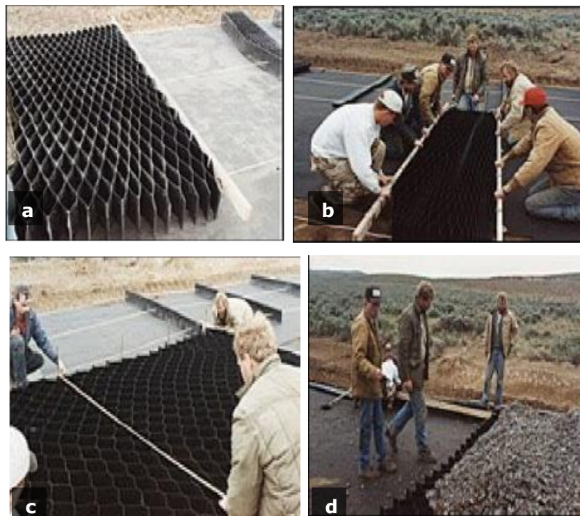
Figura 2.6 – Sequência de instalação de uma camada de geocélulas. a) posicionamento da geocélula; b) e c) abertura do reforço; d) preenchimento (AMBEDKAR, 2006)
