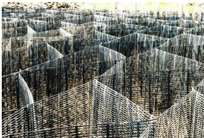
Figura 2.5 – Camada de geocélula feita a partir de geogrelhas pronta para receber o material de preenchimento (TENSAR, 2008)
