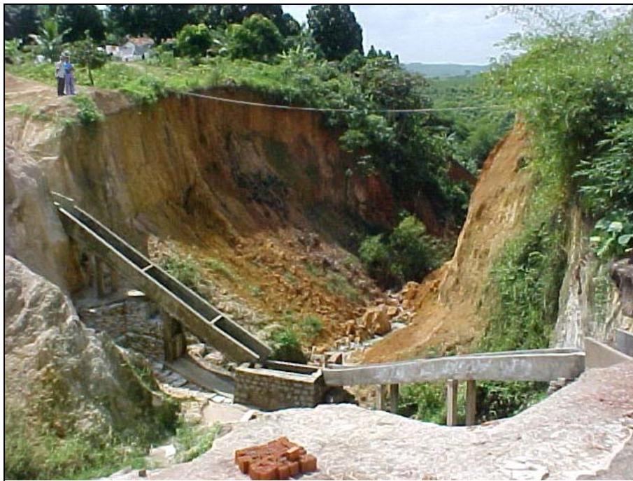
Figura II.16 - Processo erosivo por voçorocamento - Araçoiaba/ PE- AGÊNCIA CONDEPE/ FIDEM (2006)
