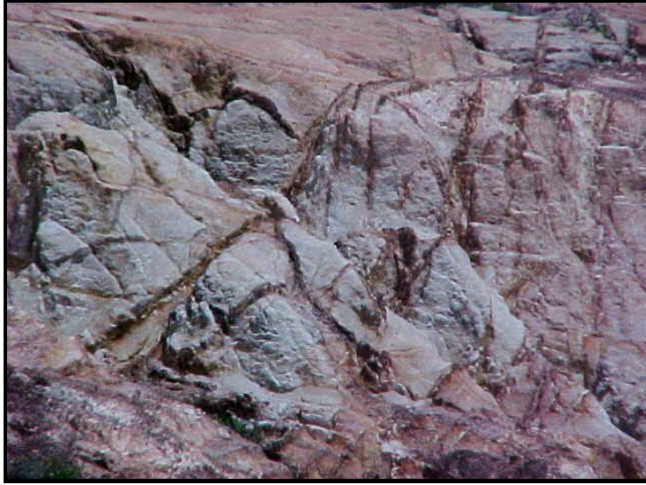
Figura III.12 – Granito intemperizado com fraturas preenchidas por óxido de ferro, SILVA (2004)
