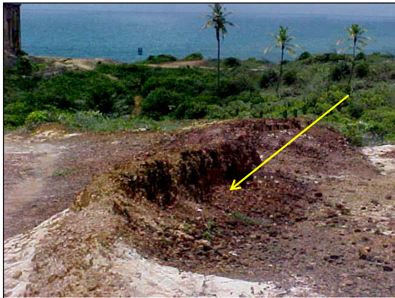
Figura III.24 – Evidência geológica de resistência à erosão.
