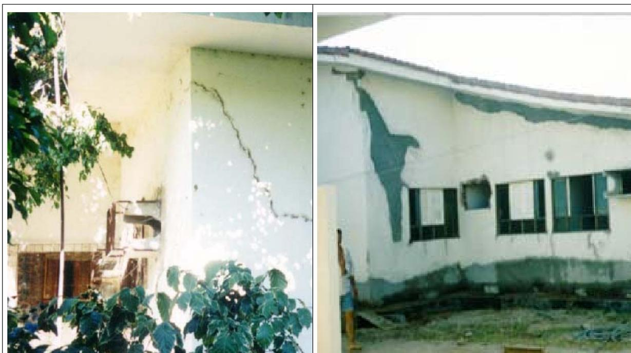
Foto 3.1 - Fissuras devido ao colapso- Privê Village- Petrolina-PE
