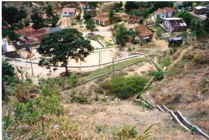
Foto IV.5 – Reabilitação da encosta S, córrego do Boleiro.
