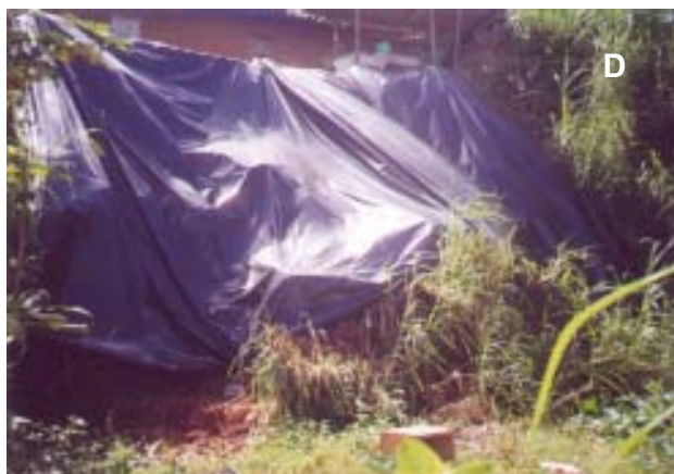
Foto IV.3 – (A) acúmulo de lixo, (B) canaleta sem revestimento realizada por morador para escorrer a água servida e (C) mesmo local da canaleta, após deslizamento localizado, e posterior proteção com lona, (D) vista frontal de (C).
