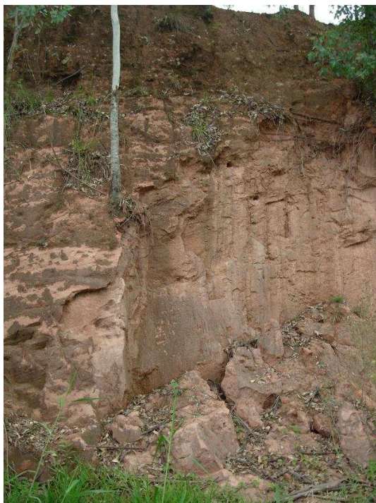
Figura 3.5 – Talude onde foi retirada a amostra de solo
