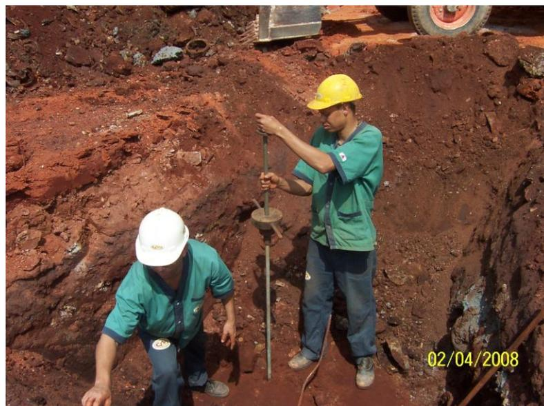
Figura 2.2 – Execução de sondagem PDL.
