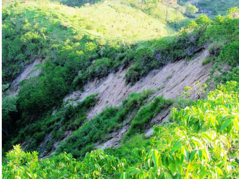
Figura 4.28 – Escorregamentos translacionais rasos em solo de colúvio. – Ponto 5
