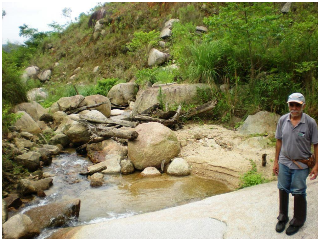
Figura 4.32 – Início da deposição do debris flow – Ponto 28.
