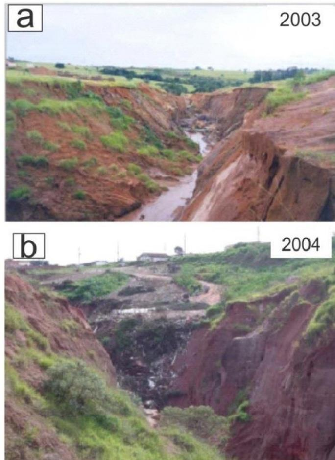
Figura 5 - Medidas não eficazes pela prefeitura a fim de conter o problema. a) Dique rompido b) Despejo de entulho e resíduos para conter erosão.
